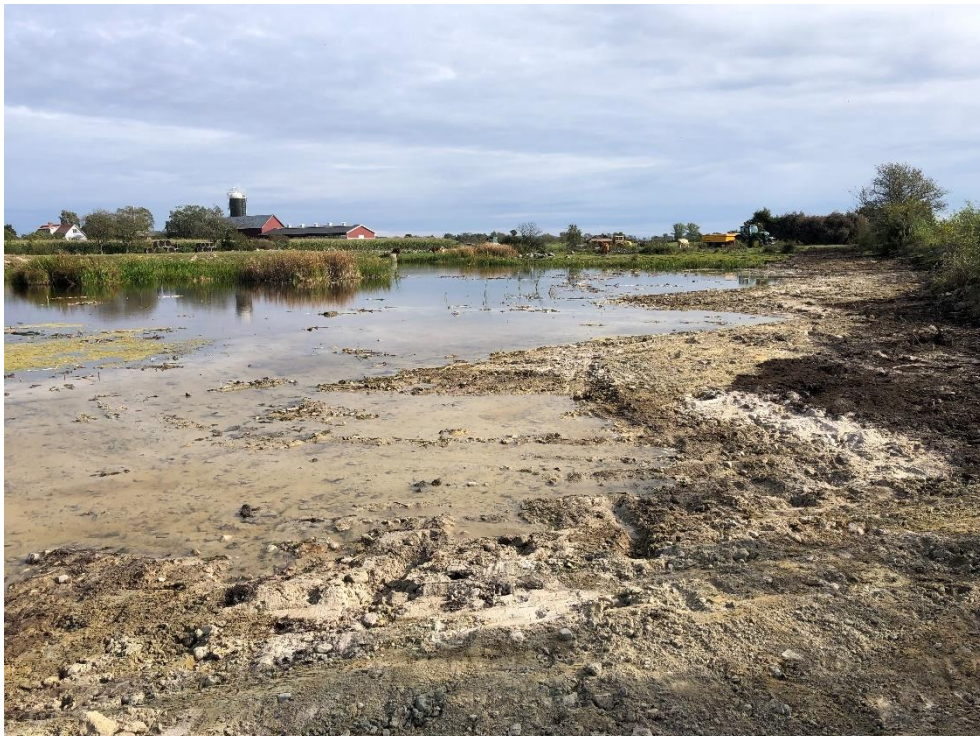
De trädbevuxna schaktmassorna har här avlägsnats längs dammens södra strand, oktober 2021. Nu väntar vi på vegetationens etablering.
