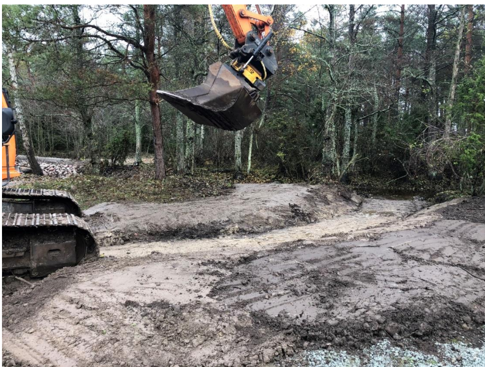
Det som ska komma att bli den nya utloppsfåran från Hyllekärr formas och ansluter till Förakanalen.
