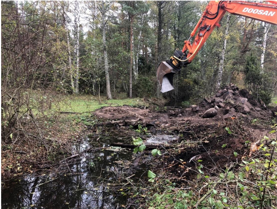
Trummorna i diket grävdes upp för att ersättas med en regleringsmunk med samma kapacitet, november 2018.
