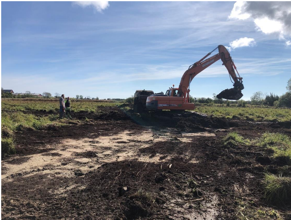
Ute i våtmarken röjdes stora videbuskage bort med rötterna och där dessa stått skapades flacka slänter mot omgivande mark.
