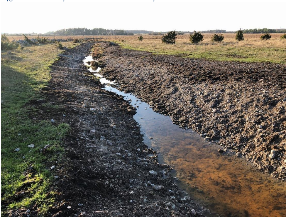
Längs diket nedströms den övre våtmarken och genom den nedre våtmarken grävdes vallarna bort och flacka slänter anlades.
