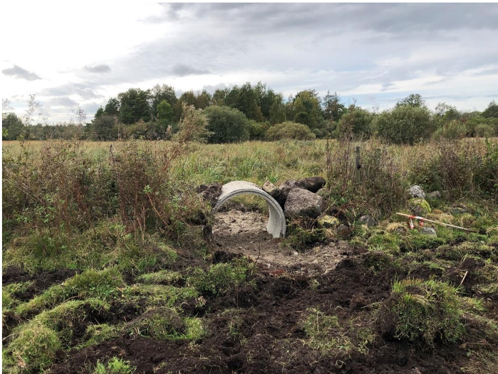
Ett tjugotal öppningar skapades i murarna, vilket nu gör att fisk under våren kan simma fritt inom hela våtmarksområdet.
