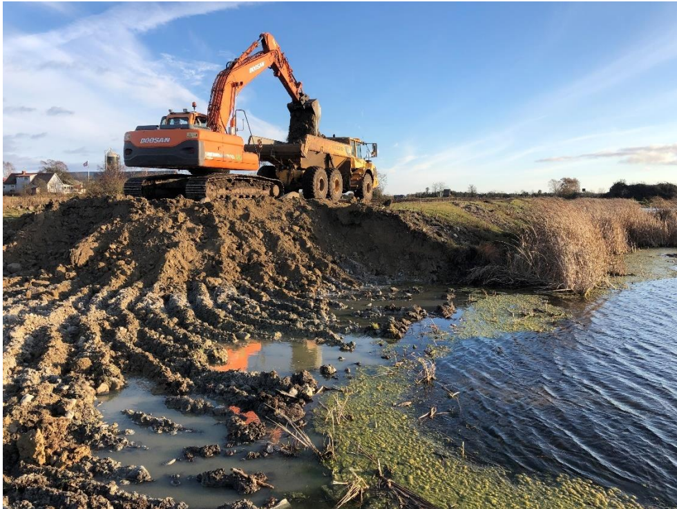
I september 2021 påbörjades arbetet med att gräva bort de femtusén kubikmeter schaktmassor som likt limpor låg runt dammen i den nedre delen av våtmarksområdet. Massorna användes sedan som markförbättring på två närliggande åkrar.
