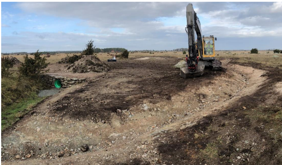
Vid den nedre våtmarken anlades en regleringsmunk och en ny bestämmande tröskel där fallhöjden togs ut via en svagt sluttande (ca 2% lutning) och cirka 50 meter lång utloppsfåra. Denna skapades endast medelst grävning eftersom markens beskaffenhet bedömdes så tät med hög halt lerjord och sten i olika fraktioner att det var både det enklaste och bästa. Varken natursten eller stenkross behövdes således fraktas dit. Den naturliga marknivån vid sidan av fåran utgör en lång breddtröskel och säkerställer därigenom den maximala vattennivån. Det gamla diket syns till vänster i bild.
