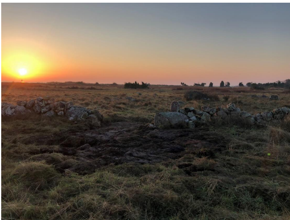
En öppning har skapats genom en av stenmurarna som genomkorsar området. Åtgärden syftar till att få en mer naturlig genomströmning av vatten och öka konnektiviteten. Stenarna placerades i ett större röse i utkanten av den blivande våtmarken.
