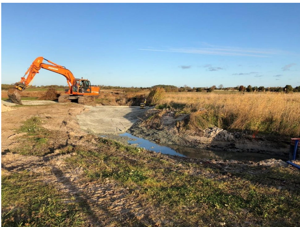
En betongtröskel placerades i diket strax under den tänka vattennivån och bäddades in i stenkross som packades väl.
