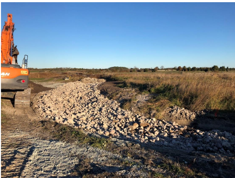
Ett ordentligt lager med natursten i olika storleksfraktioner fördelades i fåran.
