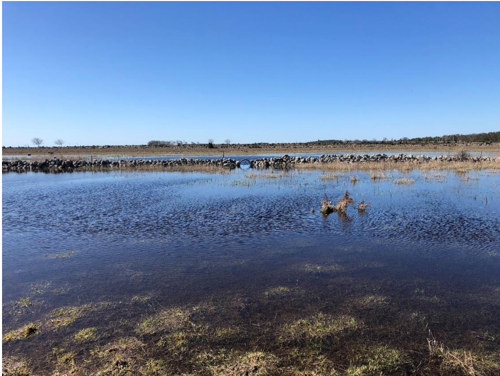
Centralt i bilden syns en öppning som med hjälp av en betongtrumma skapats i muren för att möjliggöra passage mellan de två delarna av våtmarken som delas av en tät och väljalad stenmur.
