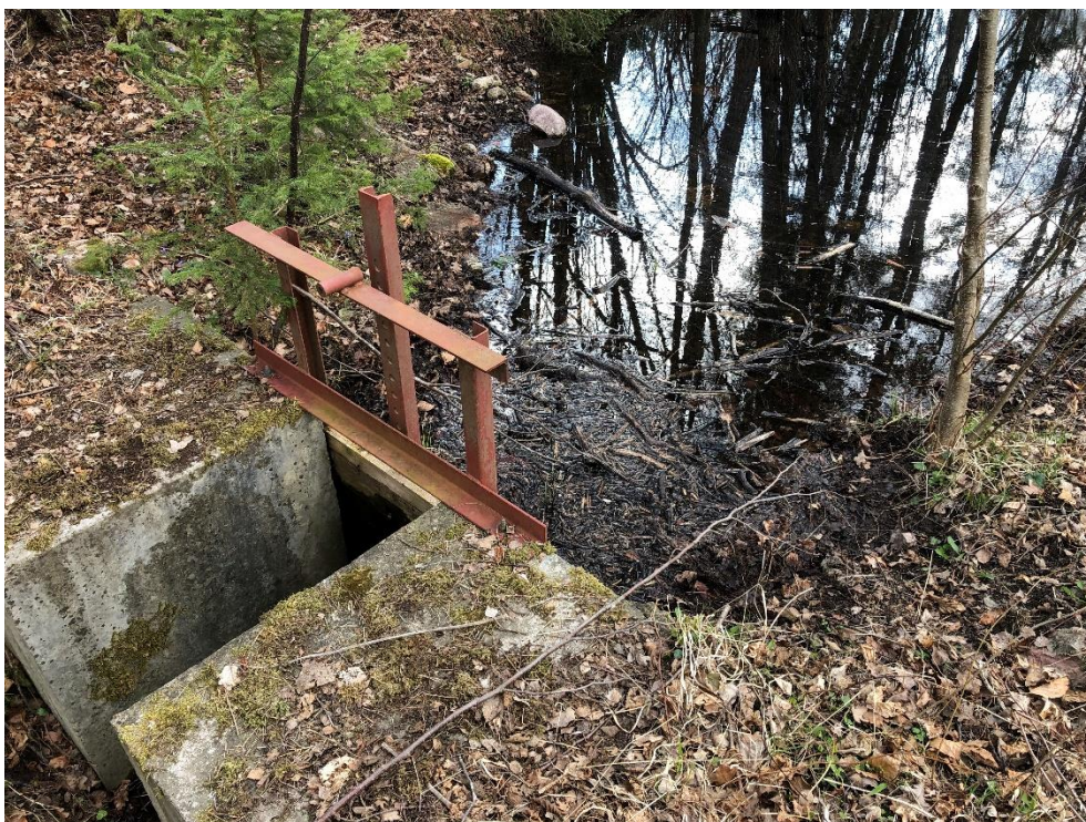
Dämmet vid Älgmadens utlopp, april 2022.
