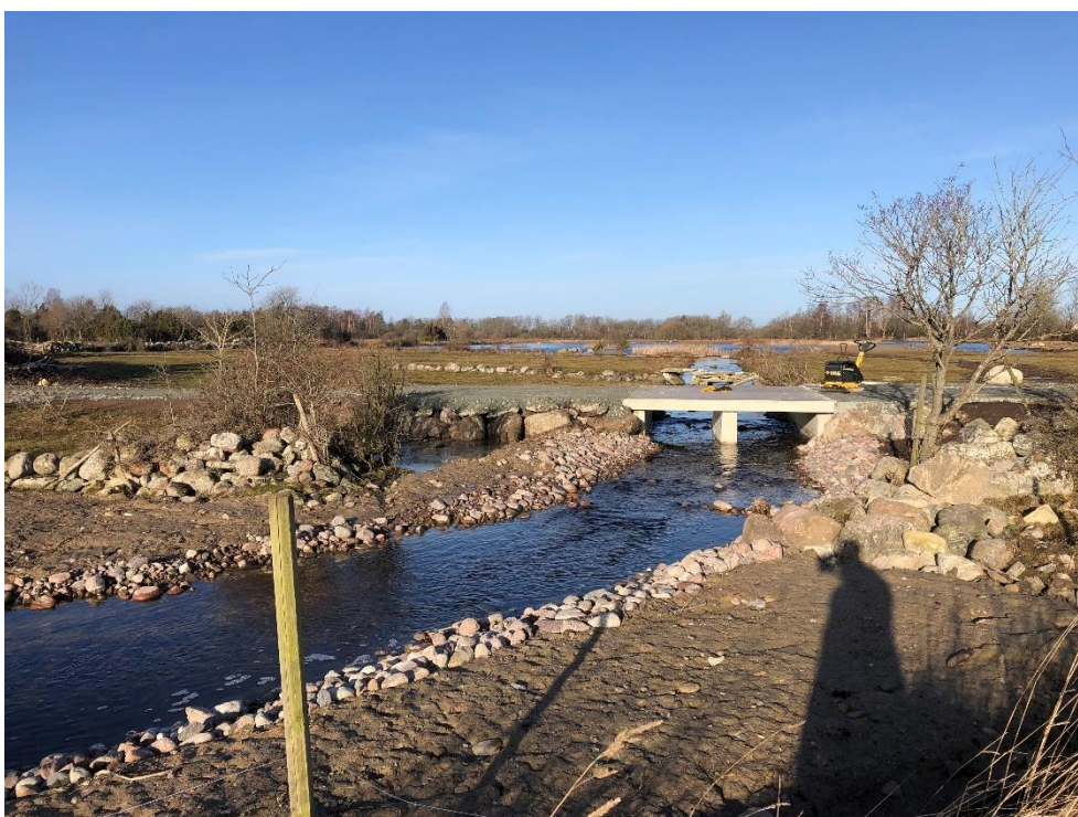
Den återskapade bäckfåran ansluter till den nyanlagda bropassagen, där jordbruksfordonen tidigare körde ner och korsade den med tiden allt bredare fåran. I bakgrunden syns Frönäs mosse.
