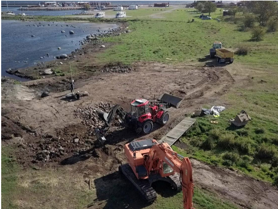
Regleringsmunken är på plats och erosionssäkras här med större natursten från båda håll. Här ses också träbron över den gamla dikesfåran, som sedan flyttades till det nya utloppet.
