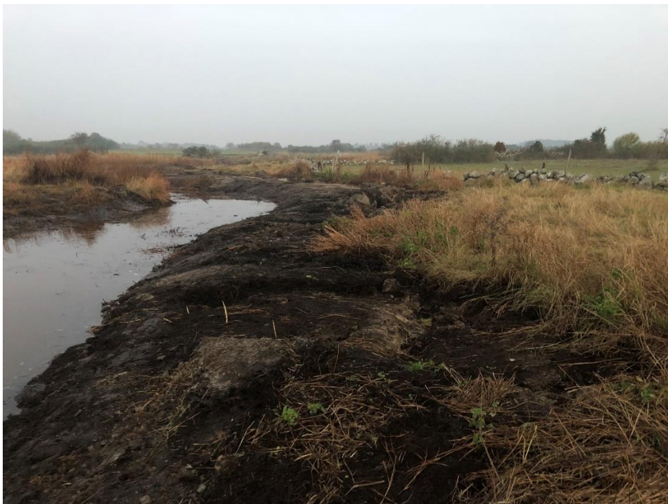
Dikesvallarna längs med diket avlägsnades...
