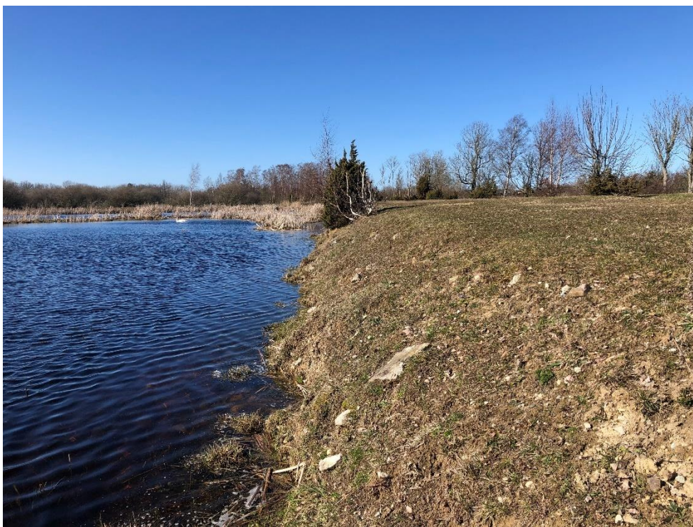
Den grävda dammen omgärdades före åtgärden av stora volymer schaktmassor som sluttade brant mot vattnet.
