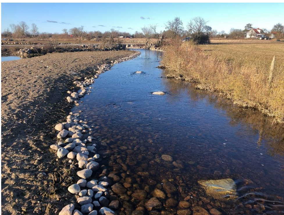
Fåran uppfylld i början på mars 2022.
