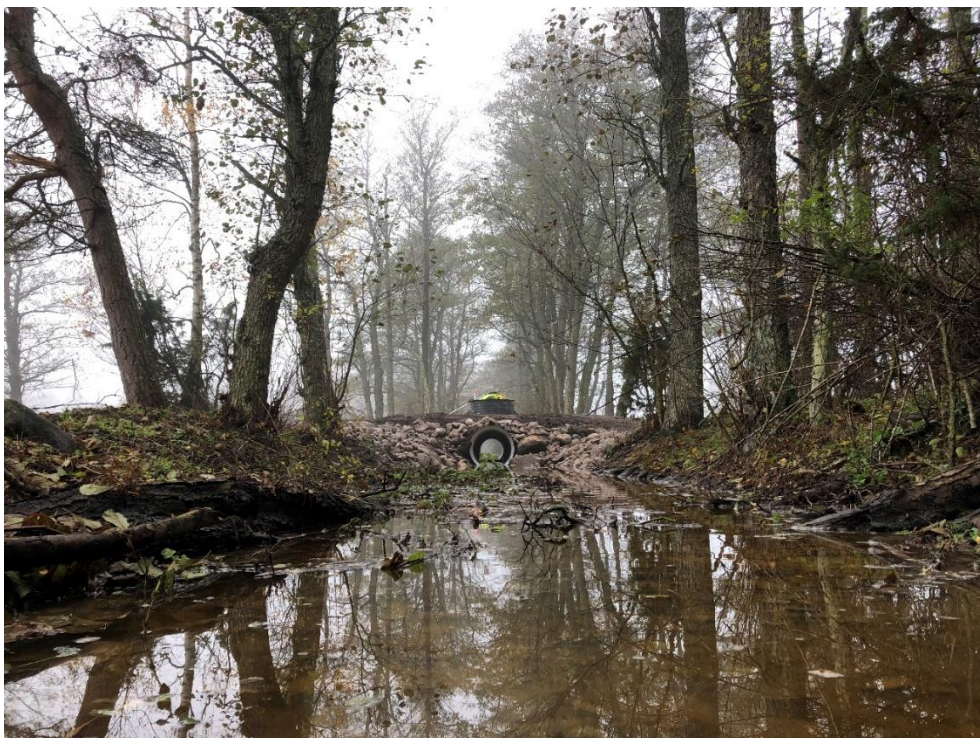
Regleringsmunken är på plats och har ersatt de två mindre trummorna vid passagen över kanalen.
