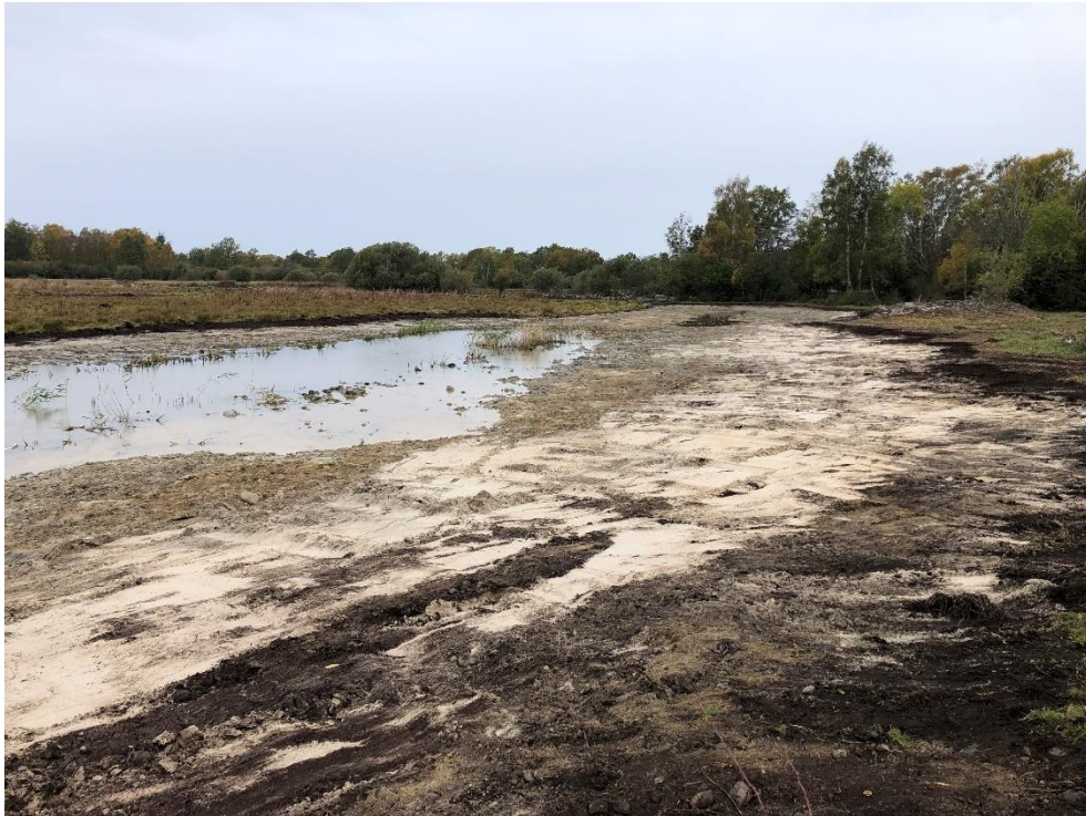
Schaktmassorna har helt avlägsnats och en flack strand ner mot den äldre grävda delen har skapats. Med tiden kommer vegetationen vandra ner mot vattnet och olika typer av växter kommer etablera sig längs den grunda strandzonens olika partier, beroende på dränkningsgrad och -varaktighet.
