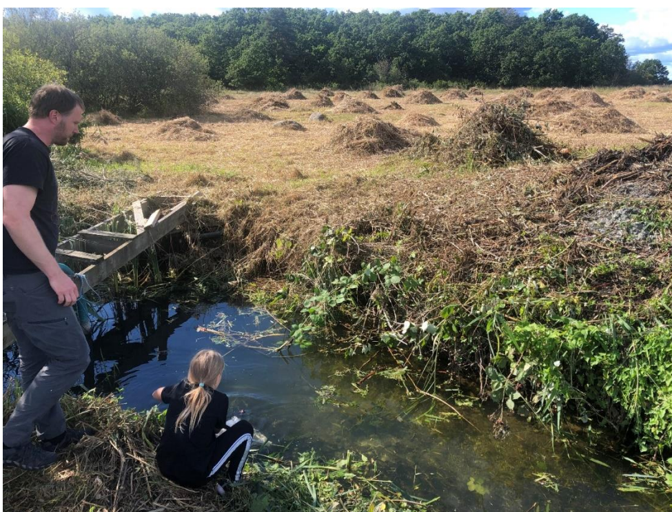
Samma vy som ovan med kulvertmynningen och diket i förgrunden efter att vassen röjts av kommunen i september 2020.
