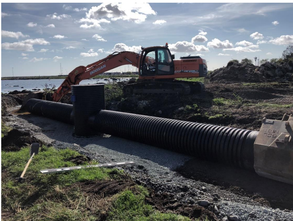
Regleringsmunken installeras strax uppströms diket utlopp.
