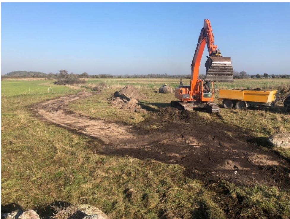
En grund fördelningsfåra (vid högflöden) tar sin form vid våtmarksområdets inlopp, oktober 2018.
