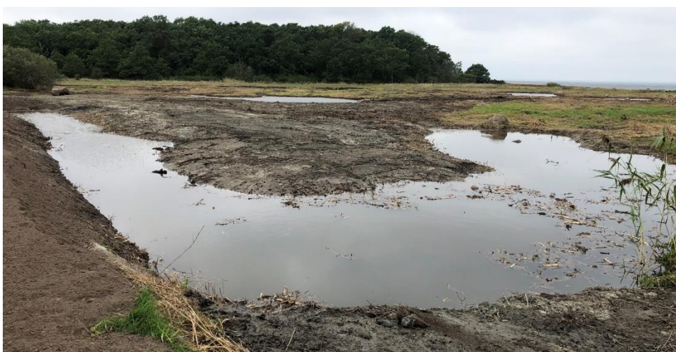
Det tidigare utloppsdiket efter åtgärd. Vallarna med rensmassor har tagits bort, kanterna har slänts ut och grävts ut ytterligare, vilket gör att det tidigare utloppsdiket nu mer fått karaktären av en avsnörpt lagun. I denna blir det havet som styr vattennivån, då den numera är "frikopplad" från själva vattendraget.
