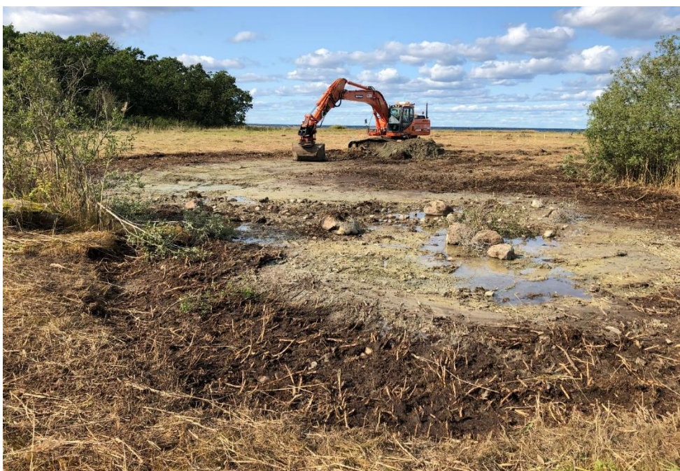
Fåran med sänkor och svämplan över den tidigare övervuxna strandängen återskapades genom att gräva bort organiskt material, september 2020.
