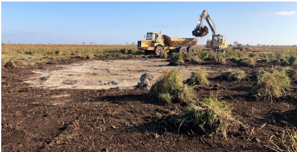
Det ljusa är sand och kalkgyttja som blottlagts när vegetation och organiska sediment (ca 20–40 cm) försiktigt skrapats bort. Från denna nivå har det sedan släntats upp till marknivå där tuvor har glesats ut.
