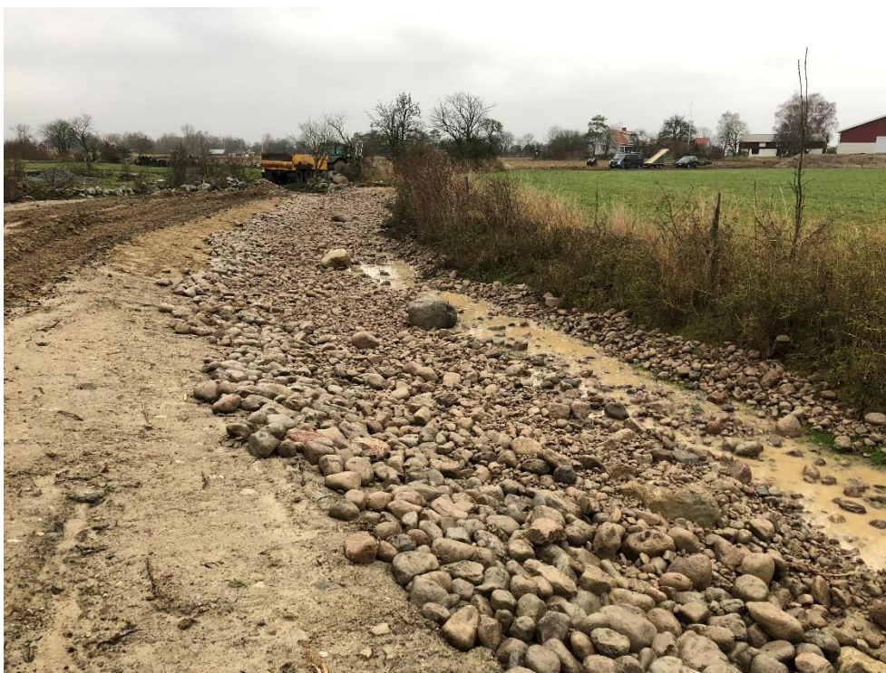
Här har jord (från tidigare schaktmassor vid våtmarken) lagts upp för att återskapa kanalsidan, därefter har natursten placerats ut för att en mer naturlig bäckmiljö där vattnet koncentreras vid lägre flöden, hösten 2021.
