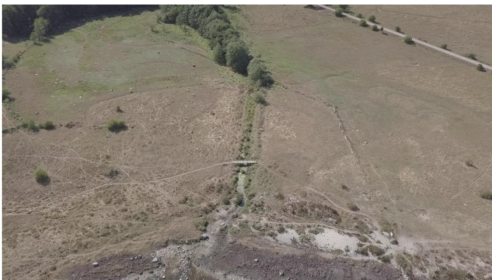
Utloppet (stranden i nederkant) från Bödakanalen vid Brokhål före åtgärd. Foto: Alexander Bjelken- dal
