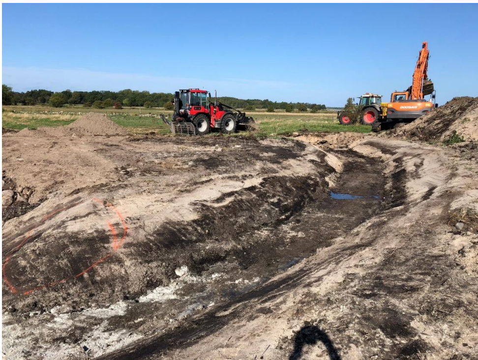
Arbetet med den nya utloppsfåran har just påbörjats.
