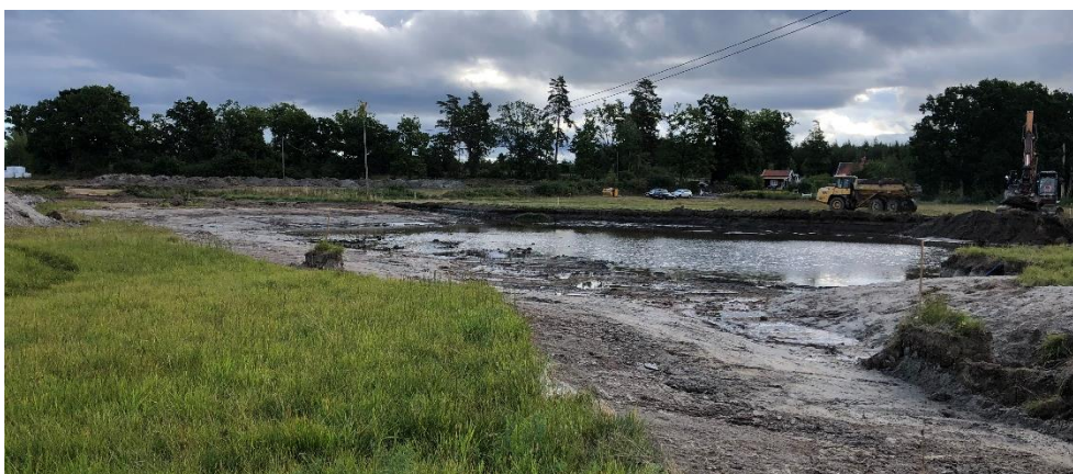
Vid Ljungnäs strax norr om Kalmar skapas under hösten 2022 en våtmark med flacka slänter i anslutning till ett dike genom att schakta bort massor. Vid en sådan våtmark behöver vegetation etablera sig för att miljön ska bli lämplig för till exempel gädd- och abborrlek liksom för att kunna erhålla en effektiv näringsretention.
